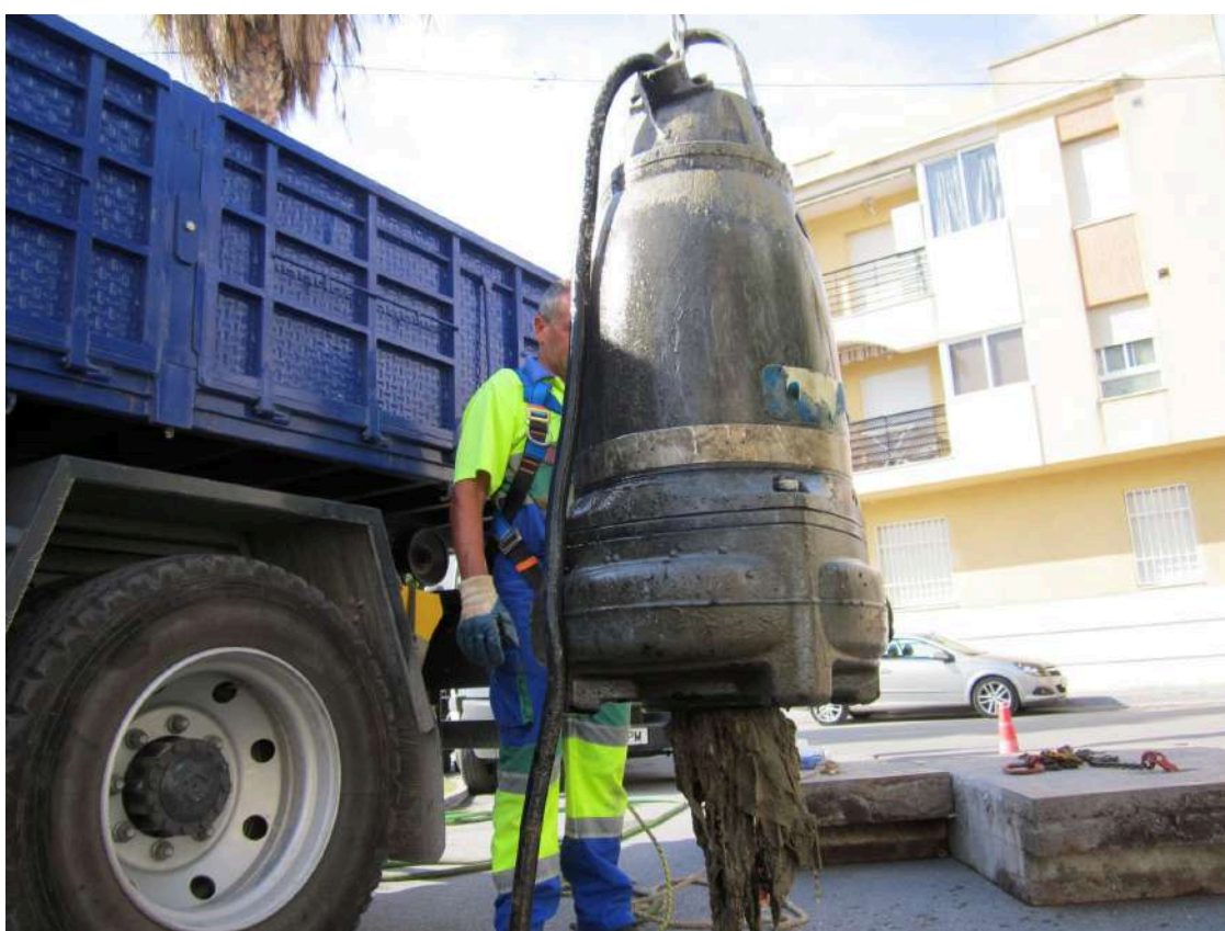
Limpieza de imbornales por parte de la empresa Aguas y Servicios (EL FARO)
