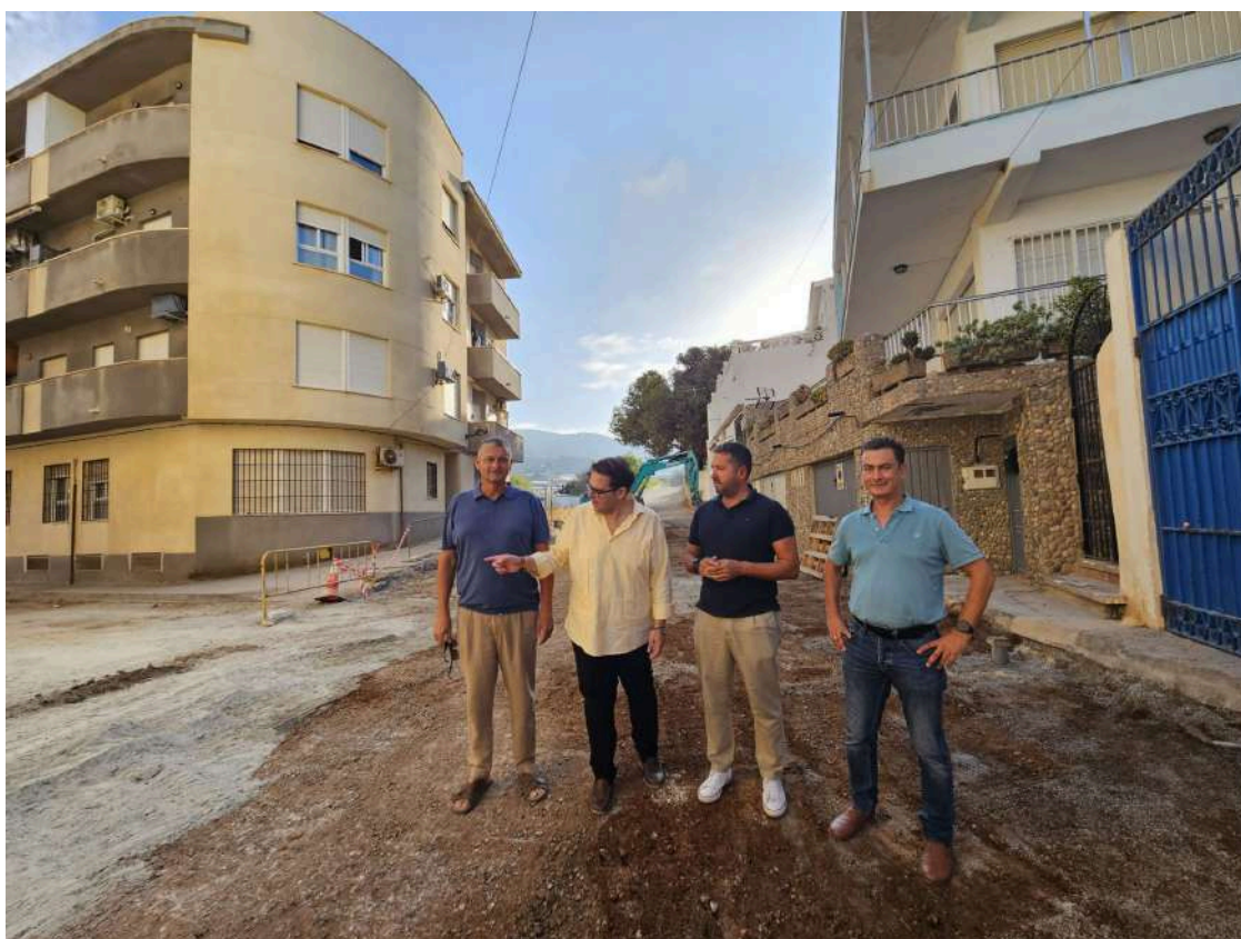
Visita de las autoridades a las obras en el Peñón de Jolúcar en Torrenueva Costa (EL FARO)
